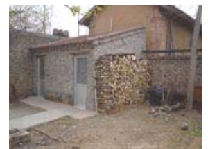
Salle de bains - toilettes
